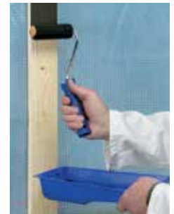
Voorbehandeling houten draagconstructie Primer SX Black
