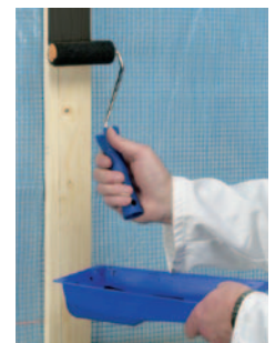
Voorbehandeling houten draagconstructie met Primer SX Black
