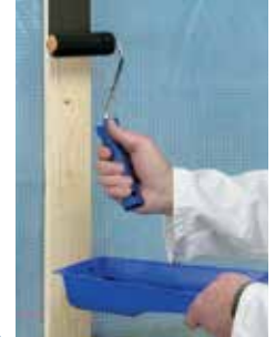
Voorbehandeling houten draagconstructie met Primer SX Black
