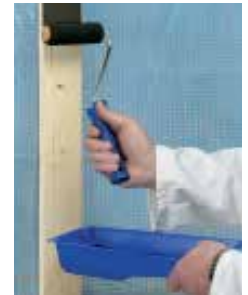
Voorbehandeling houten draagconstructie met Primer SX Black
