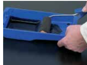
Voorbehandeling houten draagconstructie met Primer SX Black
